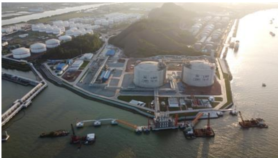
广州 LNG 应急调峰气源站
